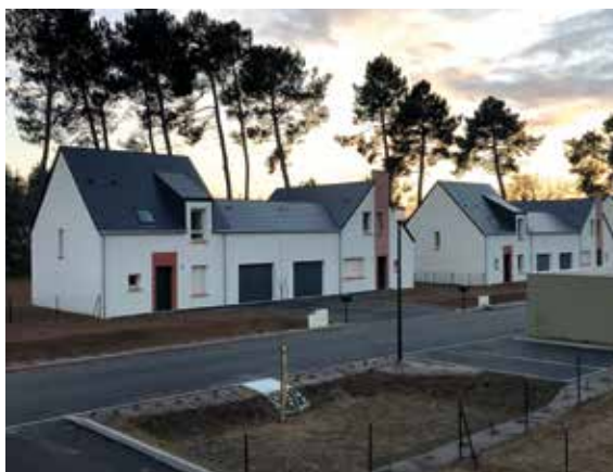
Mançelle d'Habitation Les Cottages de la Lande
